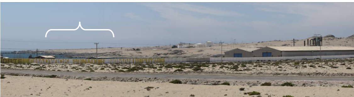
Punto 6. Detalle de la vista anterior. Entre acceso a Caldera y acceso área de estudio. Se observan las instalaciones de COPEC.
