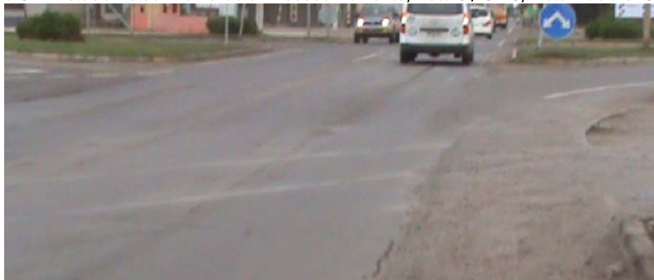
Figura 9-2: Estado Actual Demarcación Acceso Poniente, Ruta 5 / C-46, Vista Hacia el Oriente
