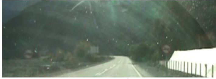
Figura 6-41: Ruta C-35, 20 Metros al Sur de la Intersección, Señal No Adelantar, en Buen Estado
