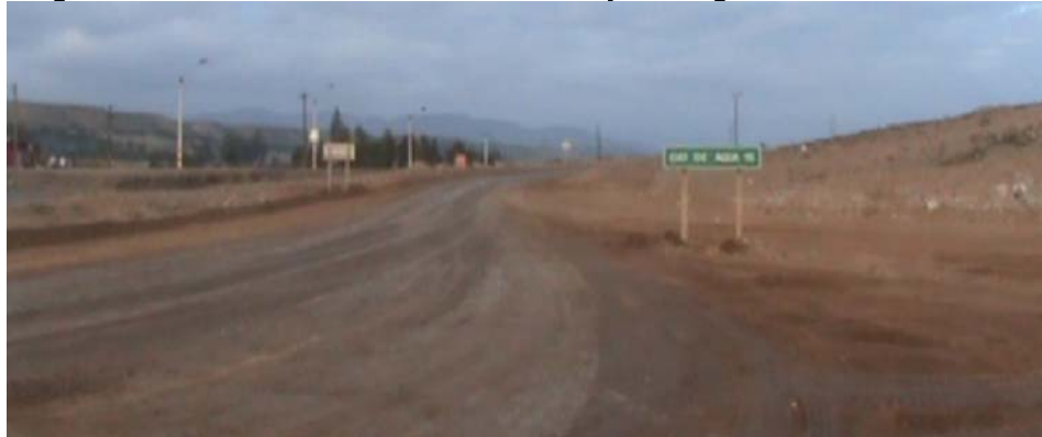
Figura 6-57: Ruta C-472, Señal Informativa "Ojos de Agua 15", en Buen Estado
