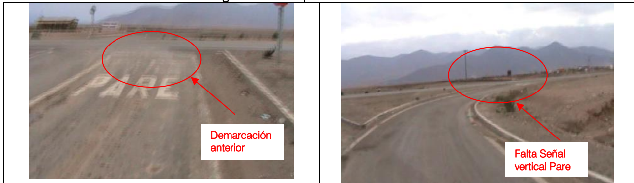
Figura 6-16: Empalme con Ruta C-569
