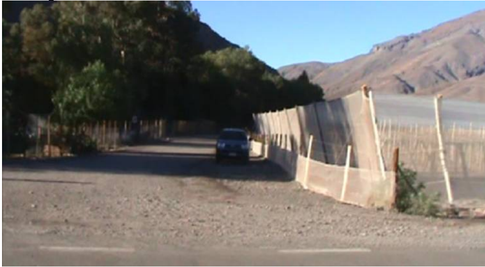
Figura 6-38: Ruta C-459, Vista Hacia el Oriente, No Existe Demarcación
