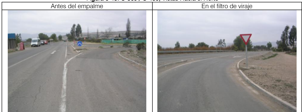
Figura 6-45: C-569 / C-485, Vistas Hacia el Norte
