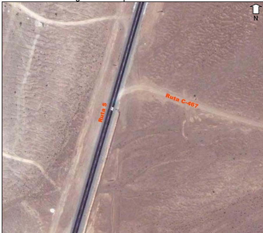
Figura 6-18: Empalme con Ruta C-467
