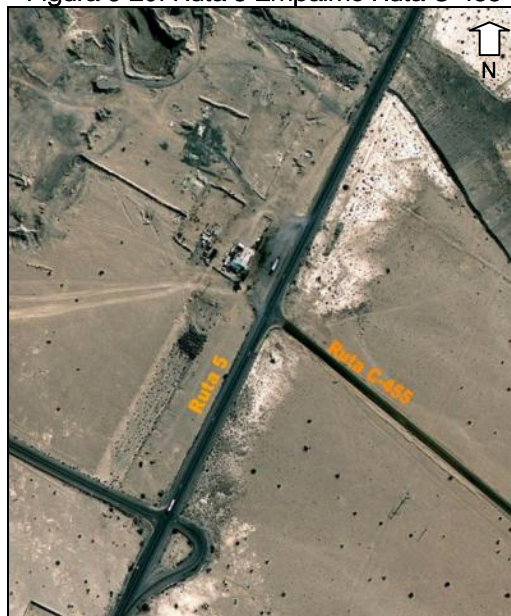
Figura 6-20: Ruta 5 Empalme Ruta C-455
