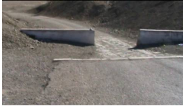
Figura 6-29: Acceso a Ruta a Amolanas, Barrera de Concreto, Vista Hacia el Norponiente
