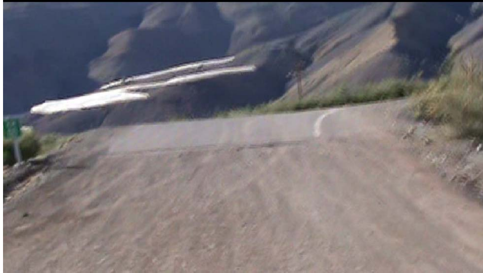
Figura 9-8: Estado Actual Ausencia Demarcación y Señal Acceso Poniente, Ruta C-35 / C-501, Vista Hacia el Oriente
