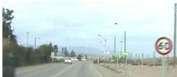
Figura 6-58: Ruta C-46, 450 Metros al Poniente del Cruce, Señales 60 km / h, Zona Urbana y Curva a la Derecha en Buen Estado
