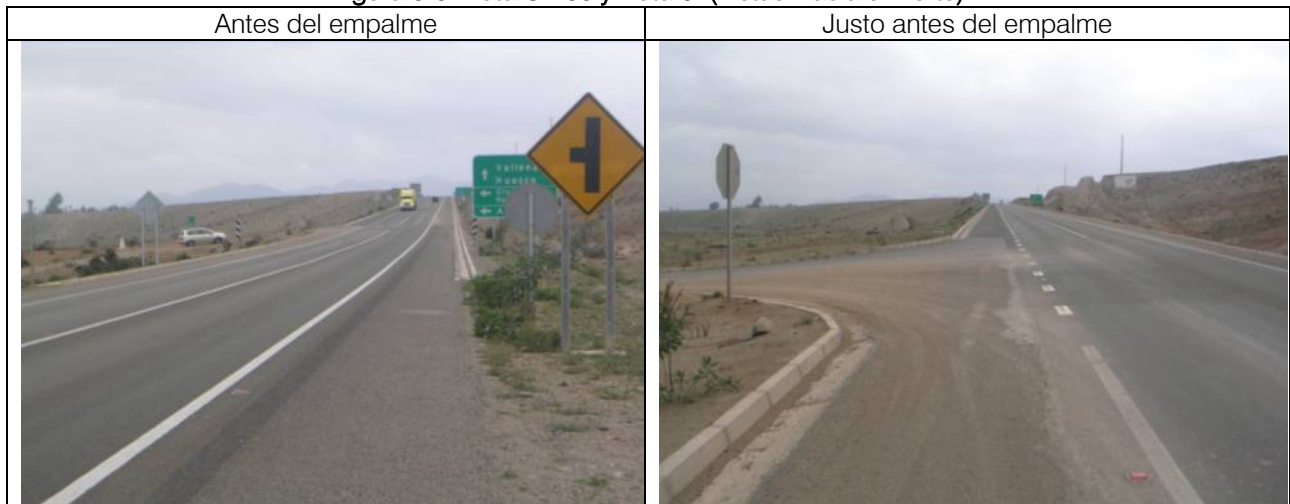
Figura 6-6: Ruta C-486 y Ruta 5 (Vistas Hacia el Norte)
