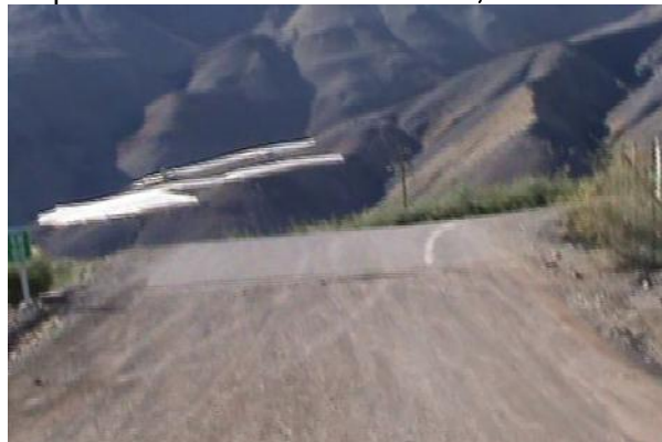
Figura 6-32: Empalme Ruta C-35 con Ruta C-501, Vista desde el Surponiente
