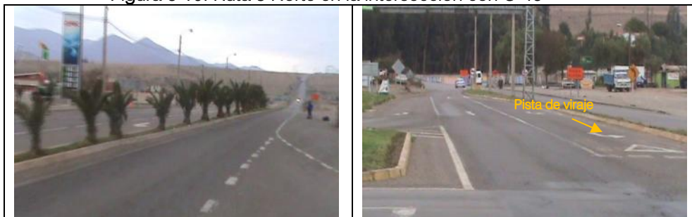
Figura 6-10: Ruta 5 Norte en la intersección con C-46
