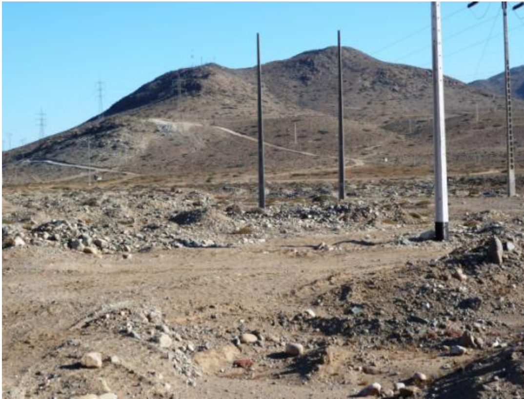
Fotografía 8.4 Panorama de los sitios de las torres T-2 y t-3 y T-4 a T-7. Vista hacia el SE. Las primeras dos torres se fundarán sobre las Gravas de Atacama y las siguientes lo harán en granitoides cretácicos correspondientes a la franja Central en terrenos de relieve suave, tal como la muestra la panorámica.
