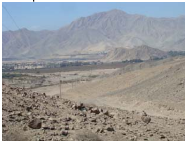
Se observa camino público, faja de servicio de LTE y camino de acceso existente
