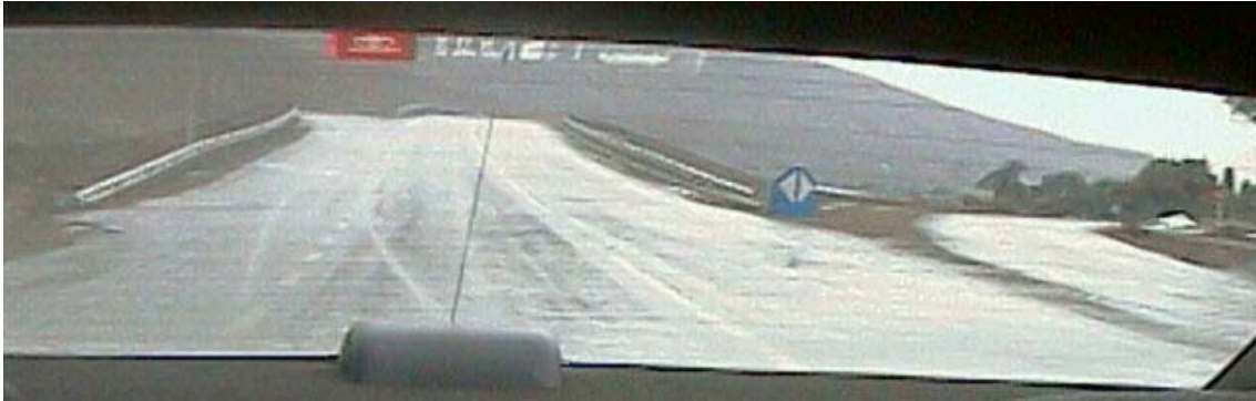
Figura 6-17: Falta de Visibilidad de Ingreso a Nantoco desde el Norte por C-35.
