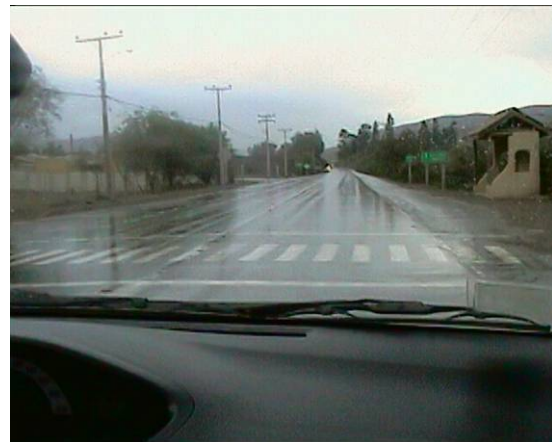
Figura 6-16: Demarcación Ruta C-35.
