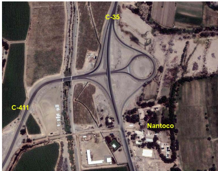
Figura 6-12: Ingreso a Nantoco por C-411. Fuente: Elaboración Propia en base Google Earth.
