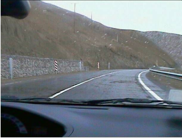
Figura 6-34: Barreras de Contención Ambos Costados de la Ruta C-35. Fuente: Elaboración propia
