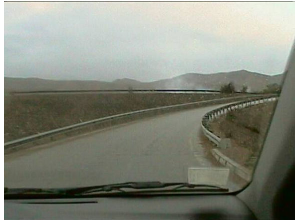
Figura 6-14: Ingreso a Nantoco, Acometida en Dirección C-35 Sur.
