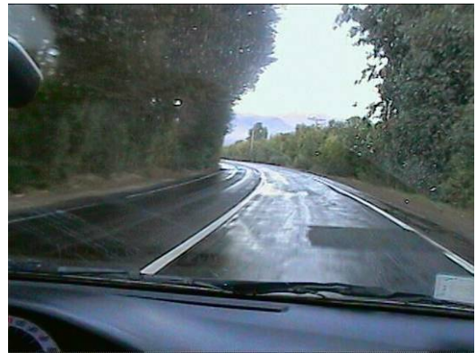
Figura 6-20: Inicio del Camino en Mal Estado.
