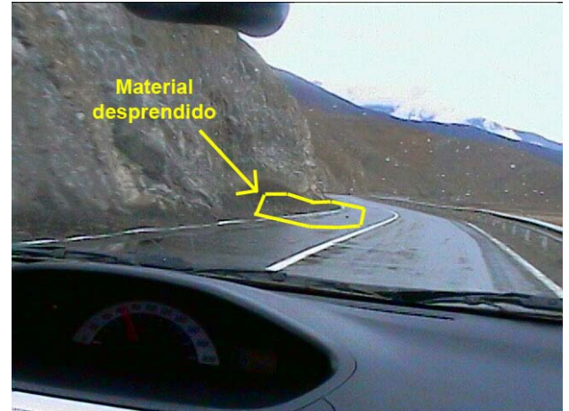
Figura 6-38: Ejemplo N°2 de Desprendimiento de Materiales.
