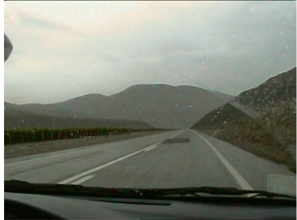
Figura 6-11: Baches en Ruta C-411. Fuente: Elaboración propia.
