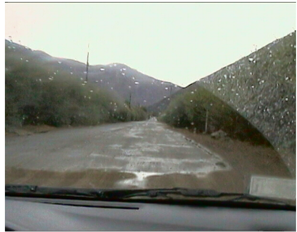
Figura 6-40: Vista desde Ruta C-35 Asfaltada hacia Camino de Tierra.
