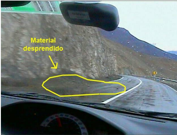
Figura 6-37: Ejemplo N°1 de Desprendimiento de Materiales.
