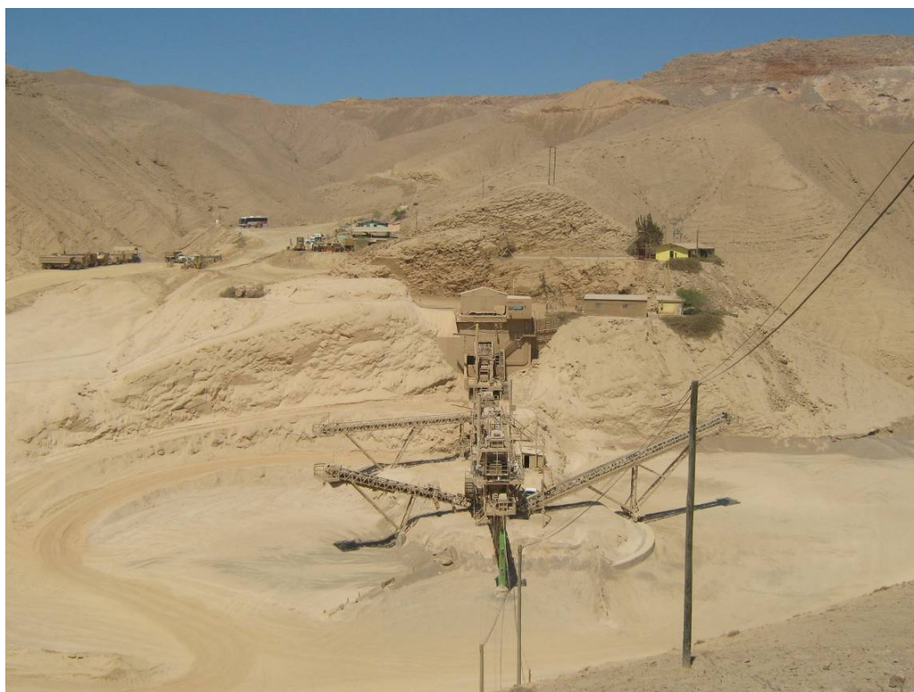
Fotografía 2.4-3 Planta de Chancado
