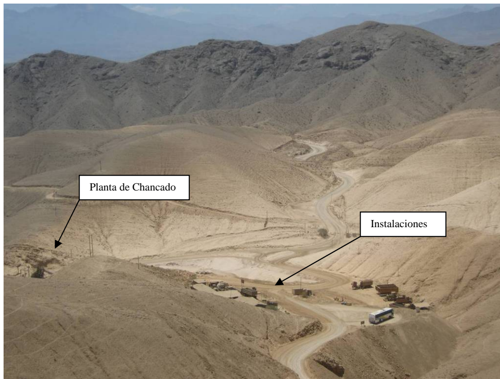
Fotografía 3.11-8 Instalaciones y Planta de Chancado, Mina Jilguero
